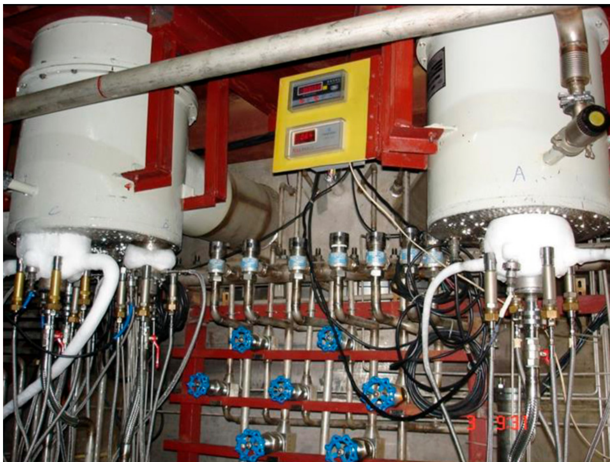
Рис. 4. Гелиевый рефрижератор СКО-EAST в Китае с 2006 года работает на базе турбодетандеров ОАО НПО «Гелиймаш»
